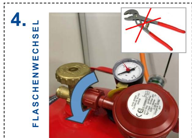
Druckregleinrichtung mit der Hand festschrauben – linksherum drehen, keine Zange benutzen
