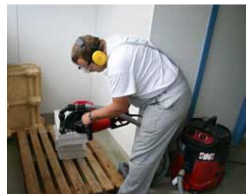
Fotos: BG BAU
