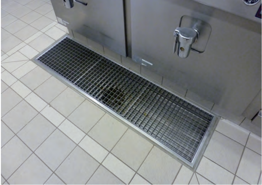
Abb. 4: Abdeckgitter oder -roste und angrenzende Fußböden müssen die gleiche Rutschhemmung aufweisen.
